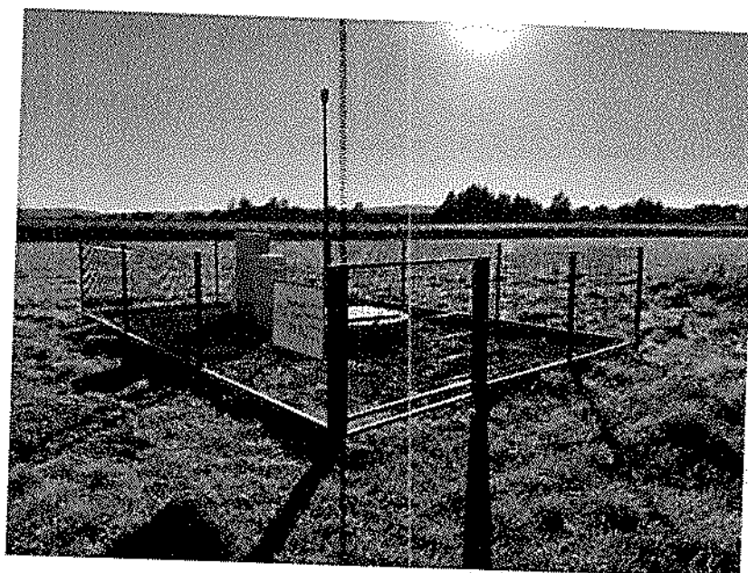
Pompownia ścieków PB 11
