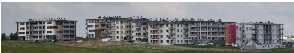
Osiedle TBS w Boguchwale
