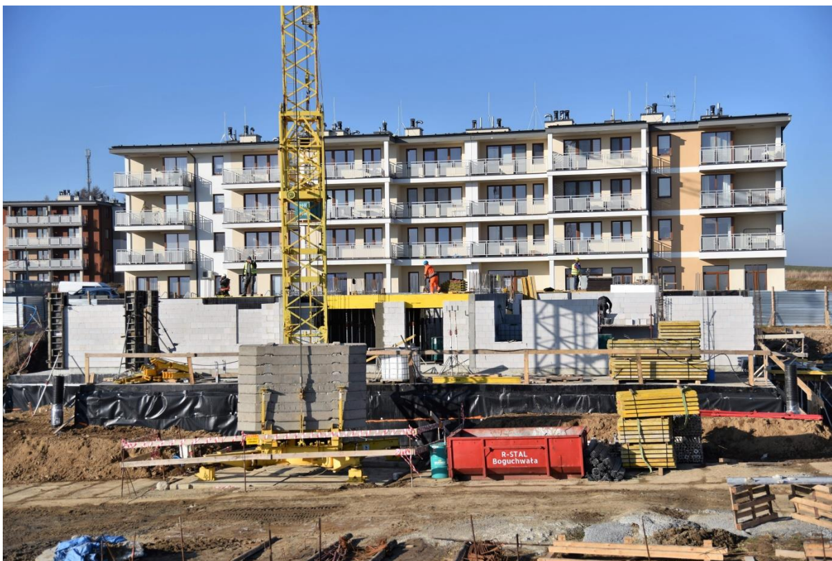
Budowa kolejnego budynku na osiedlu TBS
