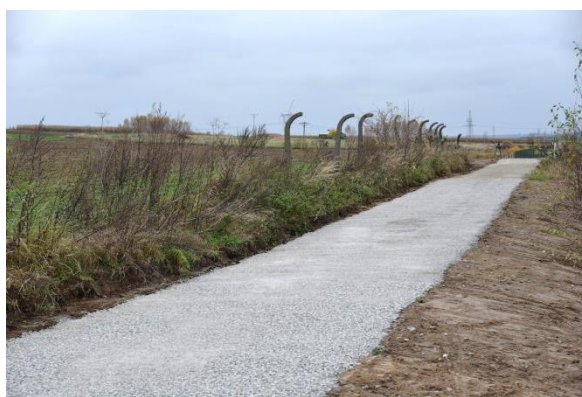
Droga w Boguchwale
