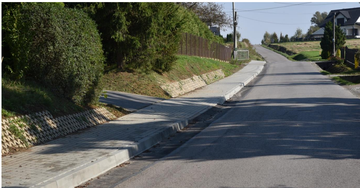
Nowy odcinek chodnika w Nosówce
