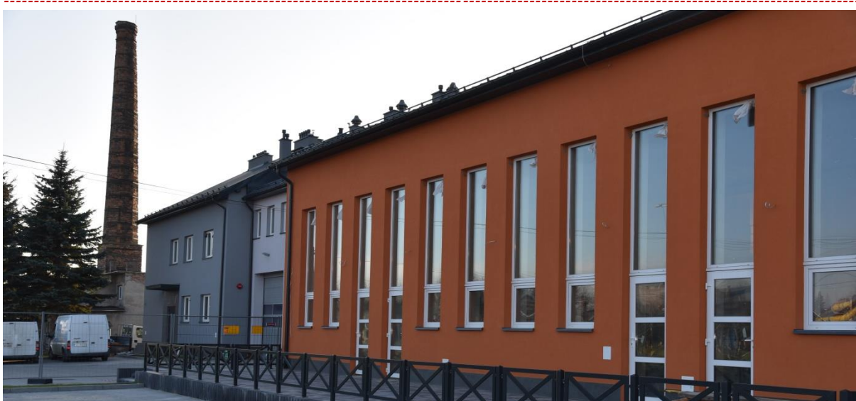
Modernizowany Dom Kultury na ul. Kolejowej
