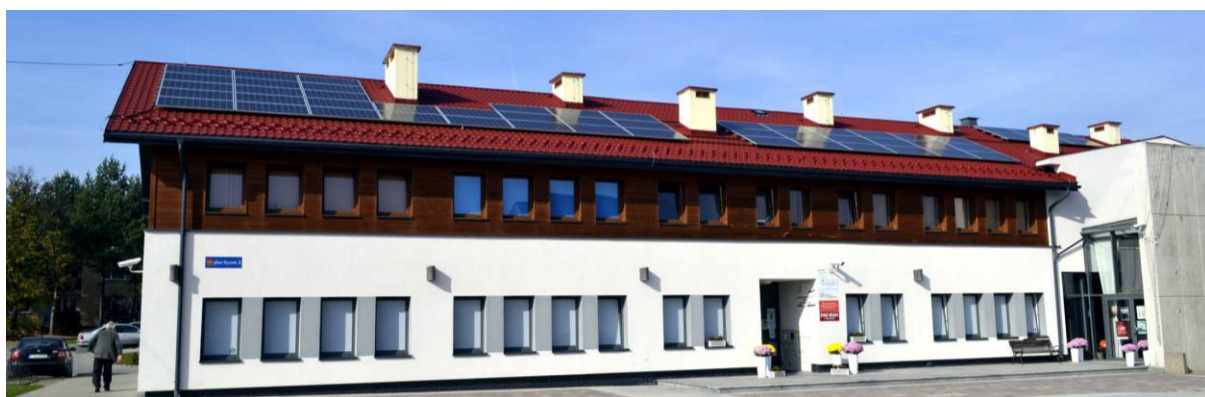
Instalacje fotowoltaiczne na budynku MCK w Boguchwale
